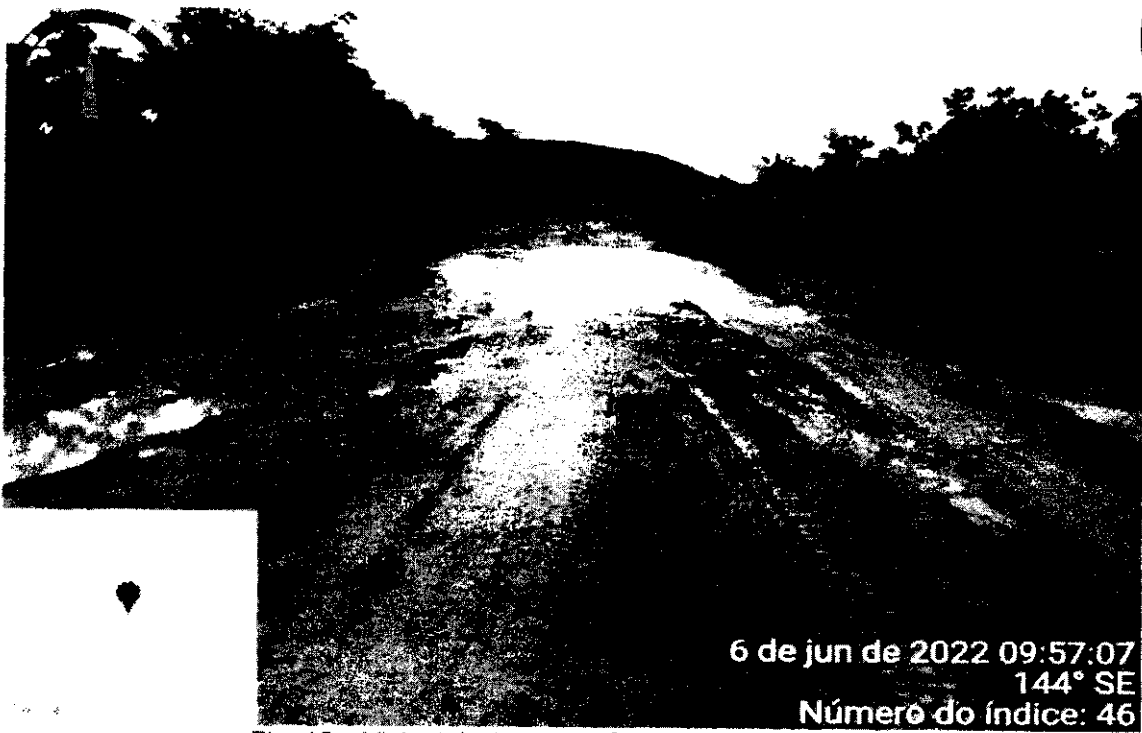
Fig. 10 – Vicinal de Acesso a Comunidade Caracanã.
