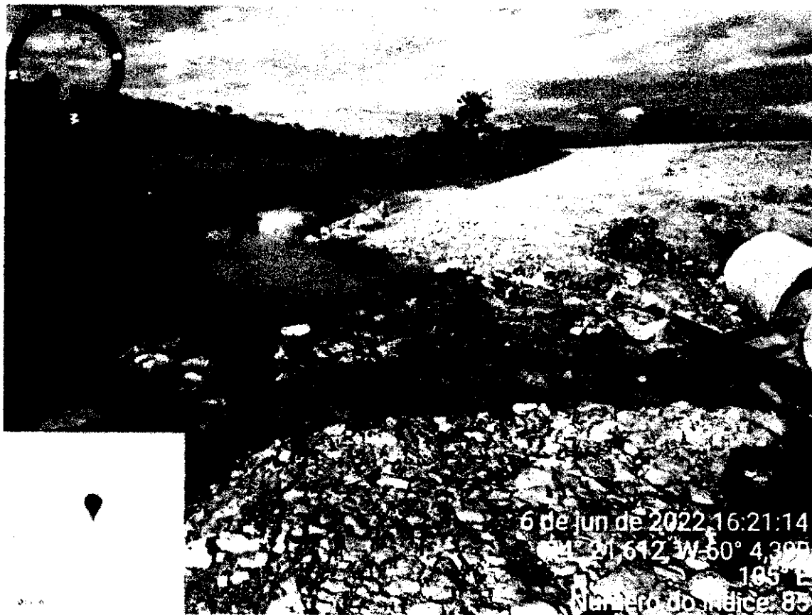
Fig. 03: Estrada de acesso a Comunidade Mutum – outro trecho da estrada onde o grande volume de água levou os bueiros.
