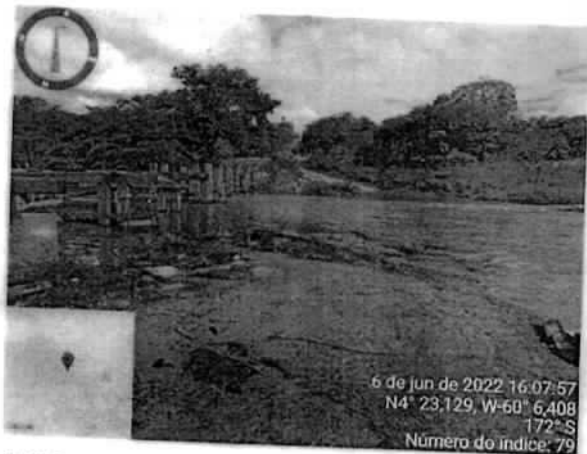
Fig. 01: Estrada de acesso a Comunidade Indígena MUTUM - Igarapé Madureza, a ponte está em construção, porém para chegar a comunidade ainda precisa passar por dentro do igarapé.
