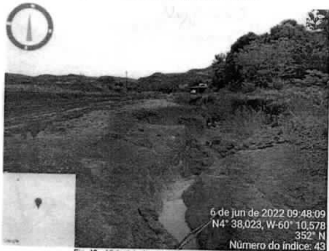
Fig. 13 – Vicinal de Acesso a Comunidade Caracanã
