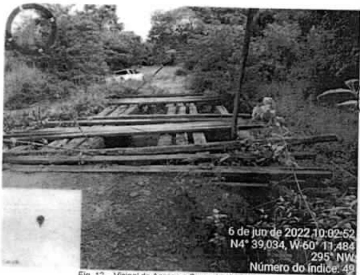
Fig. 12 – Vicinal de Acesso a Comunidade Caracanã
