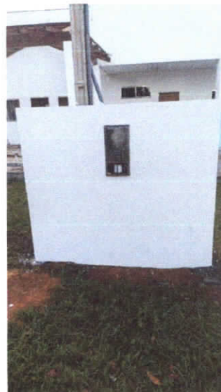
confecção de mureta
