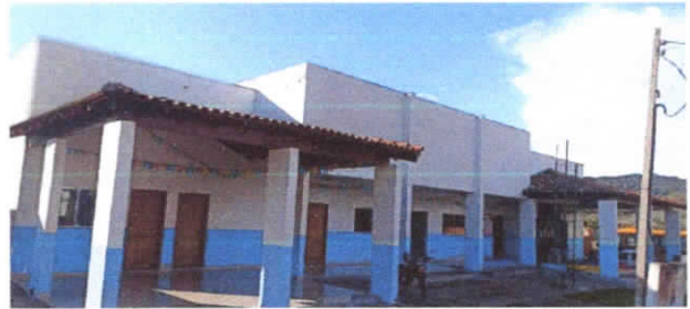
obras antes do inicio
