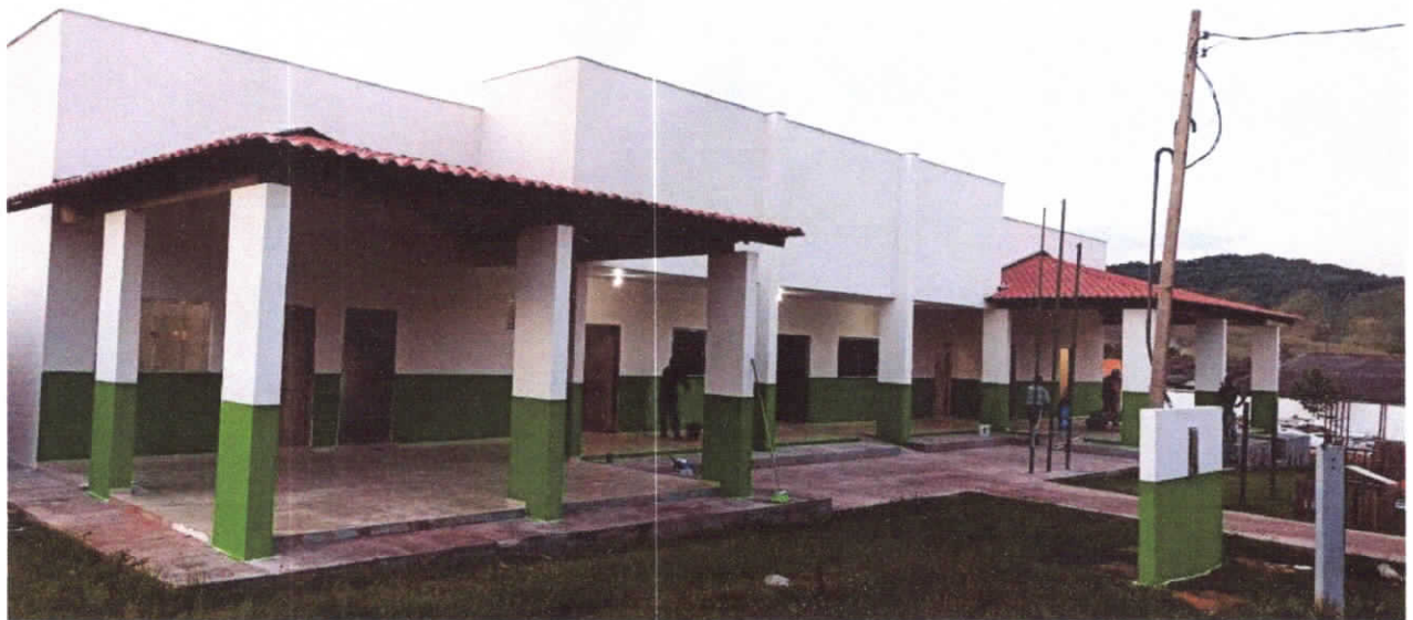
Prédio da Secretaria de Educação Reparado
