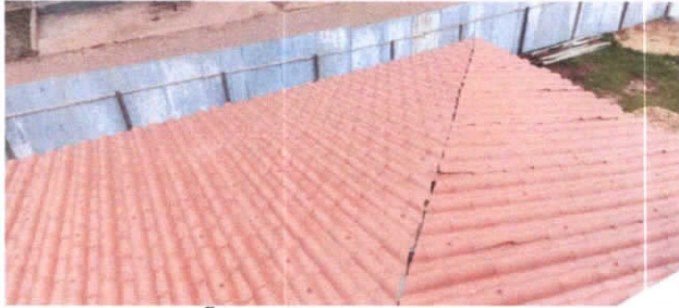
SUBSTITUIÇÃO DAS TELHAS
