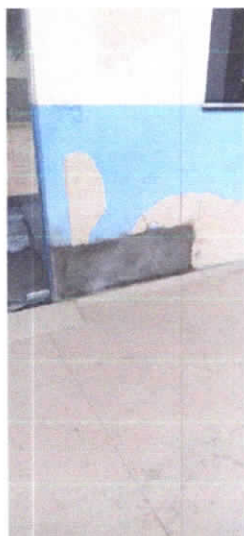
Recuperação de reboco
