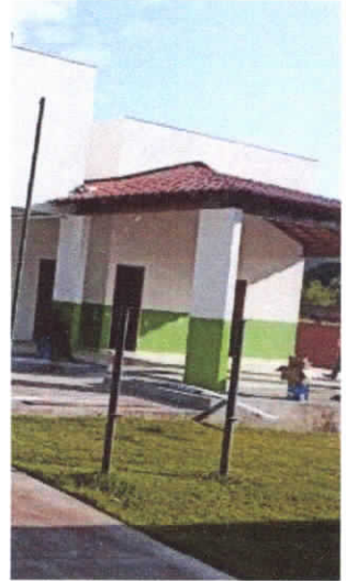
telha varanda e pintura
