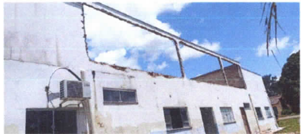
Remoção de empenas
