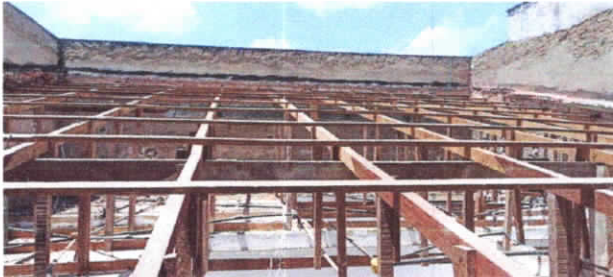
Remoção de remoção das telhas e tramos
