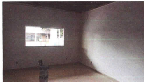
paredes emassadas
