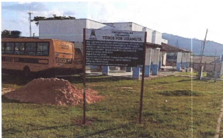
Placas da obra
