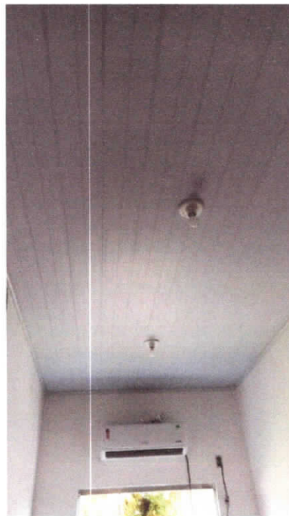
Substituição do Forro
