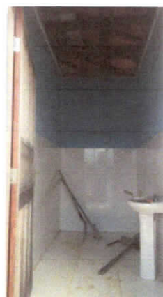
recuperação dos banheiros
