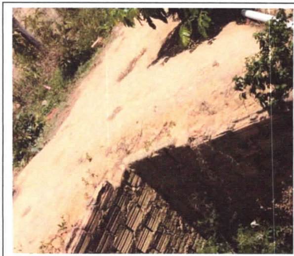
Foto 2: Parede da Fachada Lateral Oeste apresenta rachaduras, pintura descamando, calçada este piso com fissuras e quebrado.
