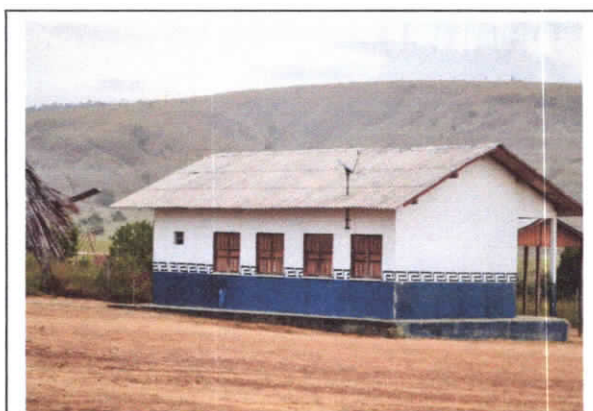
Foto 3: Parede da Fachada Lateral Leste
