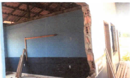
Remoção de Janelas
