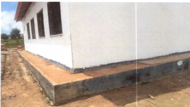
Recuperação de calçada
