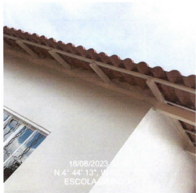
fechamento das beiras do telhado e pintura do beiral
