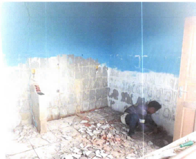
Remoção de azulejos
