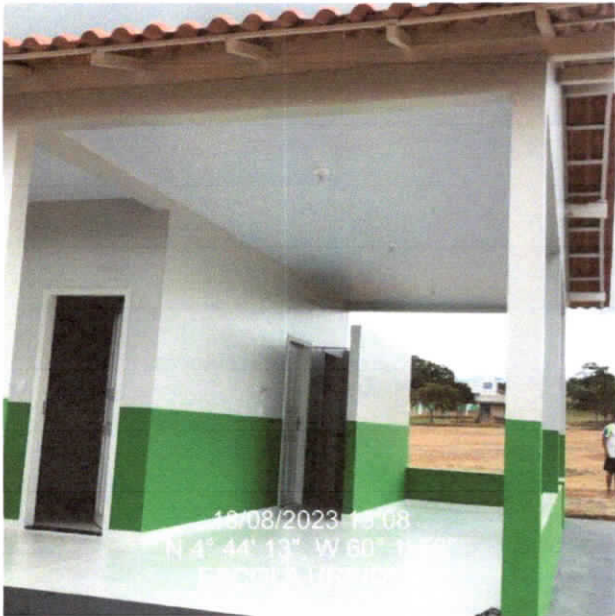
Banheiro e refeitório
