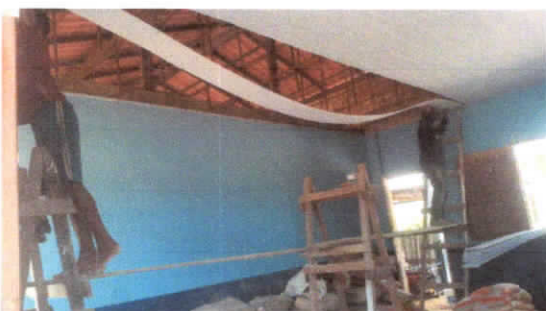
Remoção de forro
