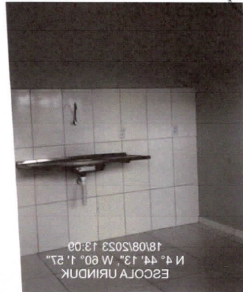
Cozinha com revestimento e pia
