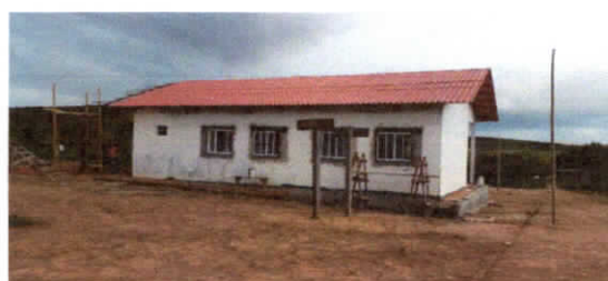
telhado e esquadrias refeitos
