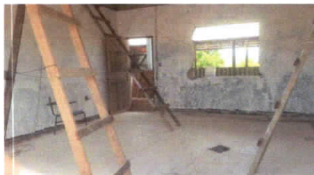
remoção do piso e forro
