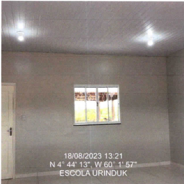
Elétrico refeito, portas e elétrico
