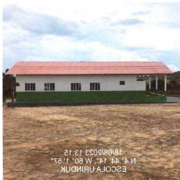
Fachada lateral esquerda
