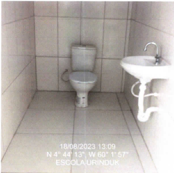
Banheiros com piso, forro e instalações
