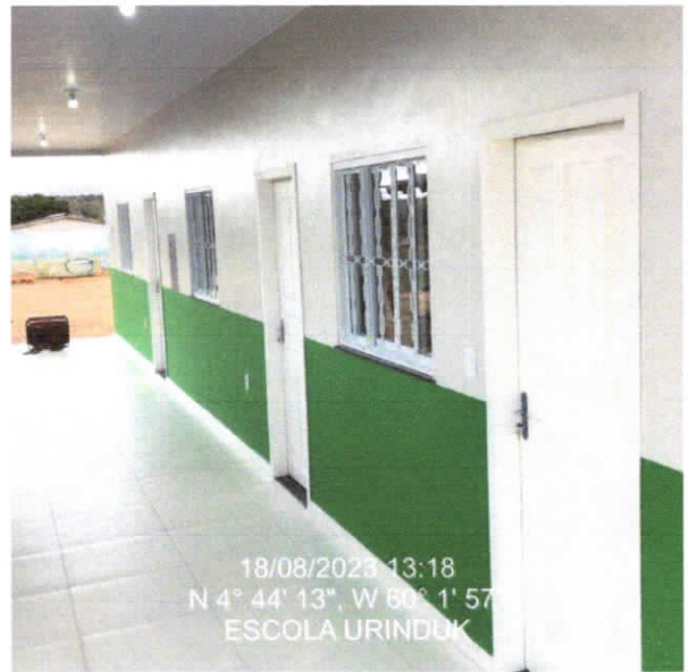
Piso, forro, portas e janelas novos
