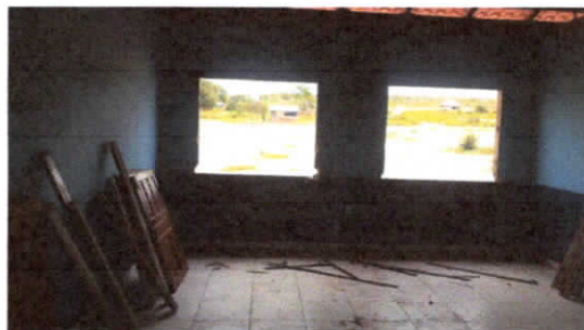
Remoção de Janelas
