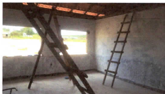
remoção do piso
