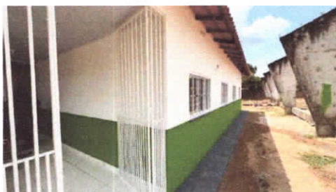
ACESSO A QUADRA
