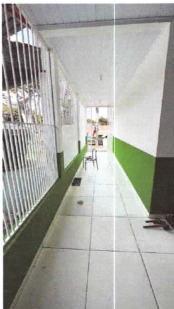
Pisos, Grades, Forro e pintura
