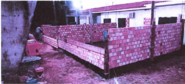
Impermeabilização e vigas baldrame
