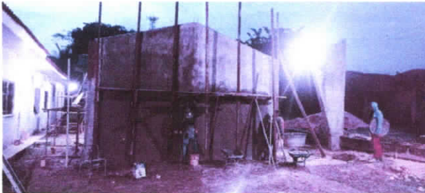
Empenas e rebouco
