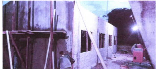
paredes chapiscadas e rebocadas
