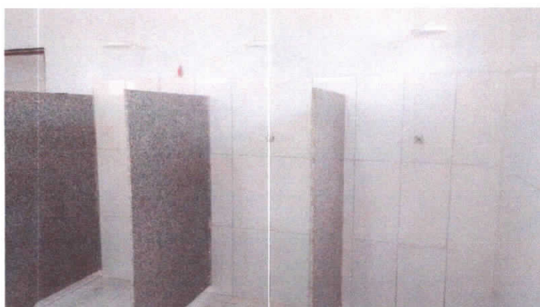
Substituição de divisórias, chuveiros e hidráulico e piso
