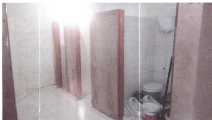
Recuperação do piso, elétrica, hidráulica e forro
