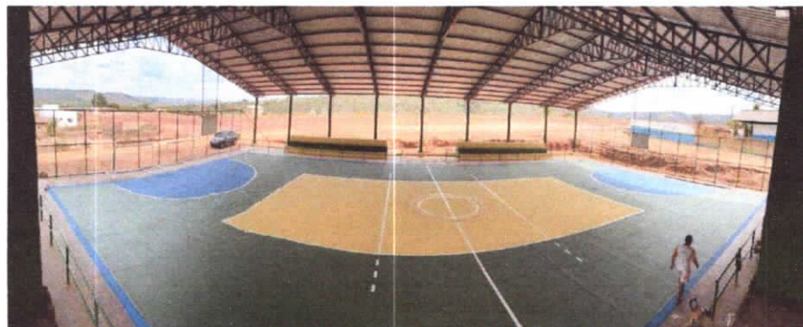
Recuperação do piso, elétrica, hidráulica e forro
