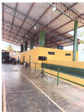
recuperação do arquibancada
