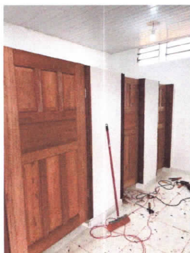
Substituição de esquadrias
