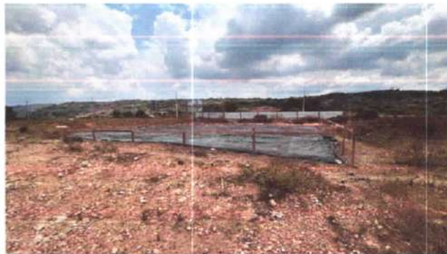
Lona de Impermeabilização
