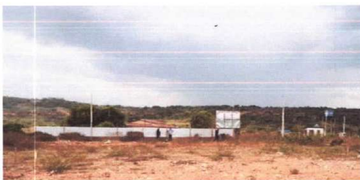
Limpeza do terreno
