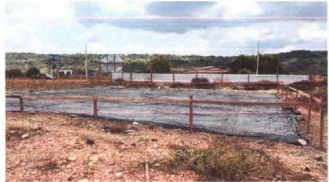
Lona de Impermeabilização Malha de radier
