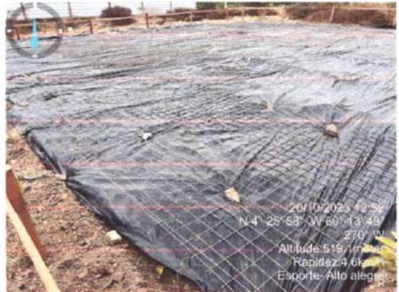
Lastro, Lona de Impermeabilização Malha de radier
