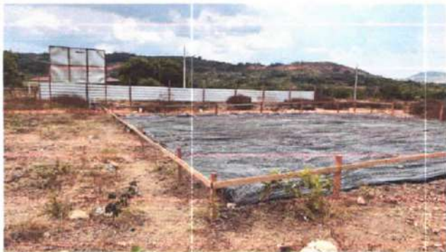
Lona de Impermeabilização Malha de radier
