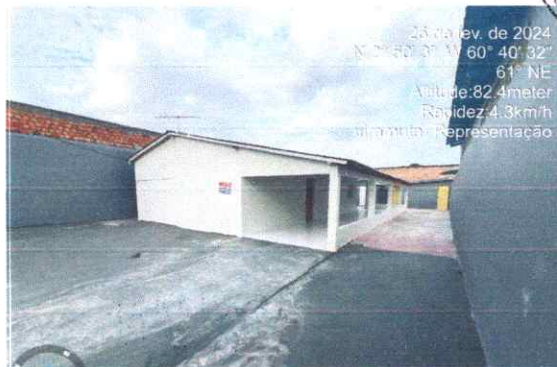
FOTO 04 – FACHADA LATERAL DIREITA
