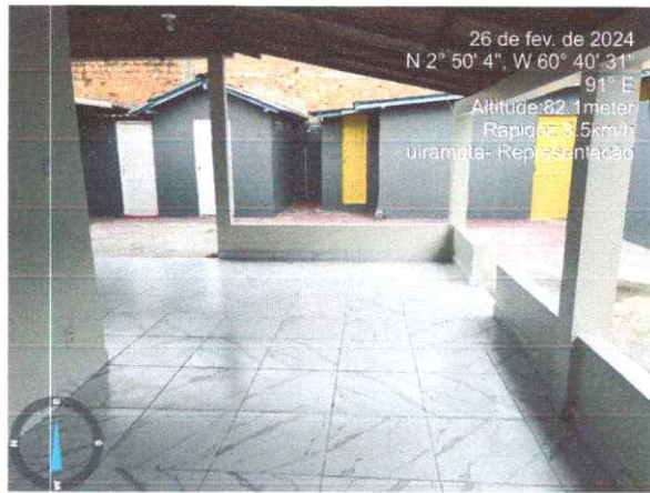
FOTO 08 – VARANDA LATERAL FUNDO
